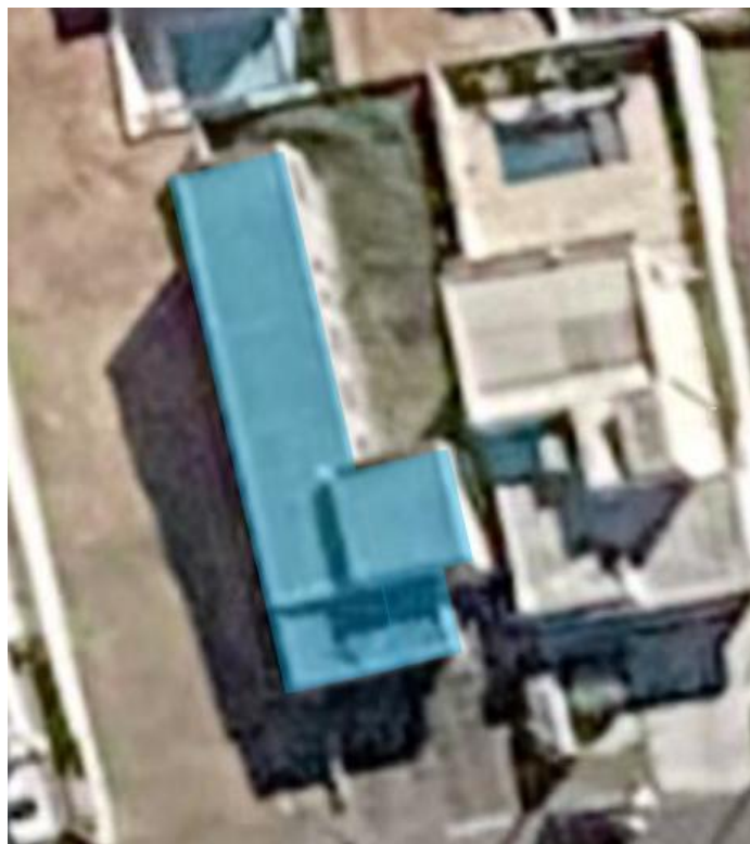
Figura 4 – Vista aérea aproximada da implantação da edificação no lote. Fonte: Google Earth.
