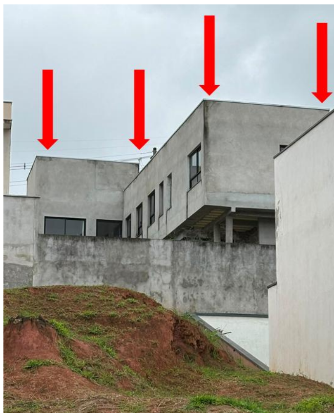
Figura 8 – Vista posterior/lateral da edificação, evidenciando a configuração volumétrica e superfícies externas sem pintura.
