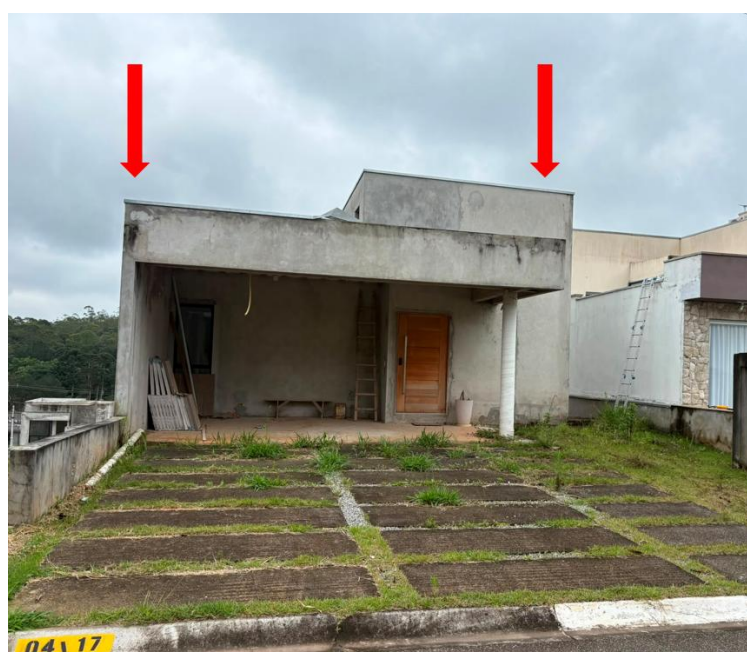
Figura 6 – Vista frontal aproximada, com destaque para a área coberta de acesso e para os elementos de fachada sem acabamento final.
