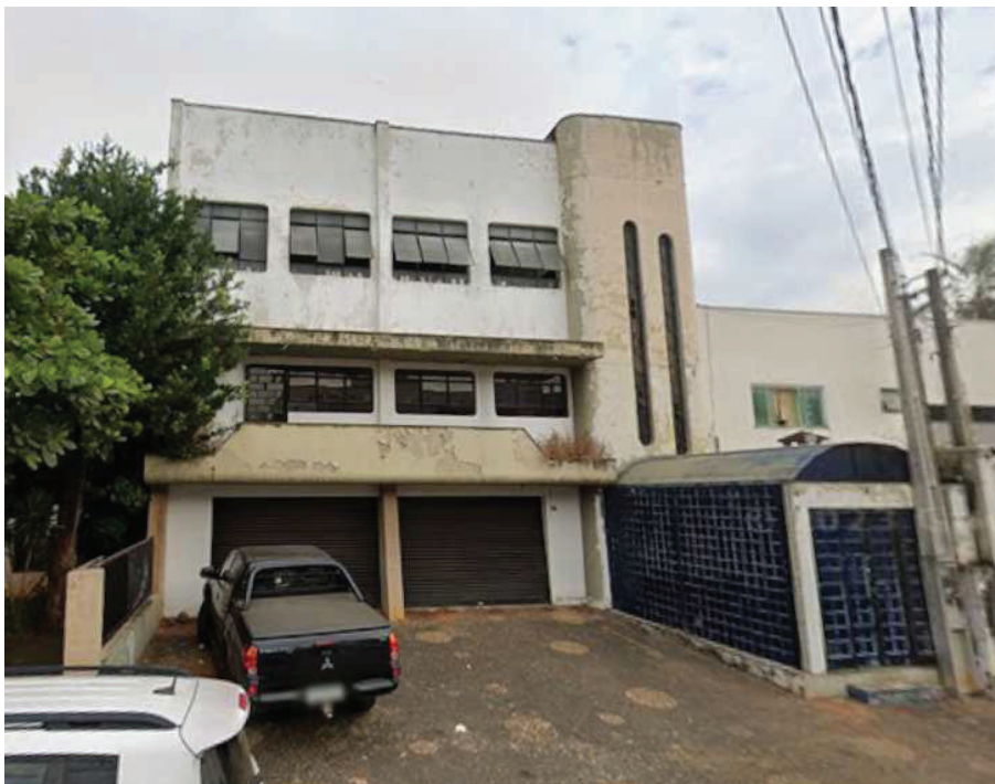
Vista da fachada do prédio
