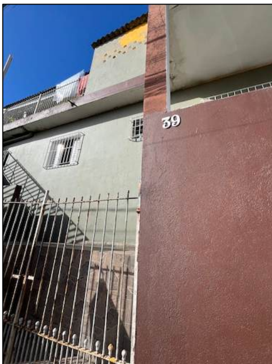
Foto 17 – Entrada do imóvel nº de porta 39
