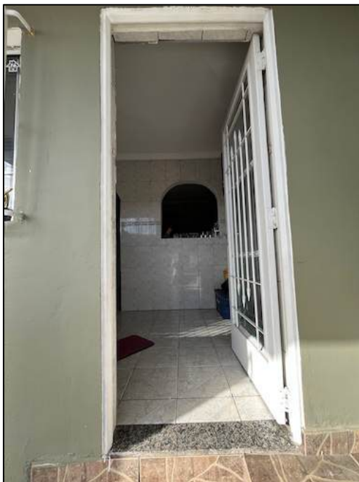
Foto 18 – Entrada no imóvel do pavimento inferior
