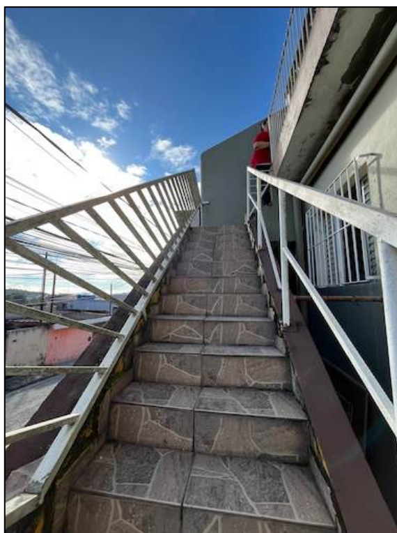
Foto 26 – Escada de acesso ao pavimento superior
