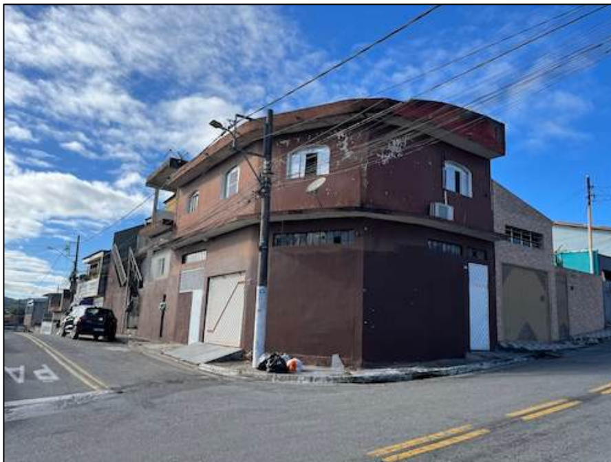
Foto 01 – Fachada/ frente do imóvel
