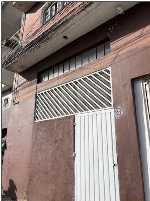
Foto 11 – Entrada do imóvel nº de porta 2
